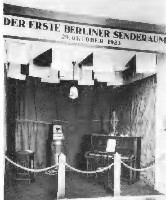
Bild 4. Nachbildung des ersten Senderraumes im 5. Stock des Voxhauses mit primitiver Dämpfung, anfangs aus Krepppapier, später aus Scheuertüchern. Hinter der Wolldeckenrückwand befand sich die Technik mit dem Mikrofonverstärker
